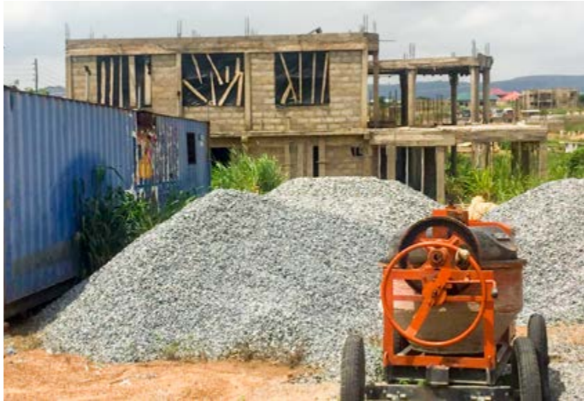
Das ist der aktuelle Stand. Man kann die spätere Form der Klinik schon erahnen. Bis zur Fertigstellung wird es aber noch eine Weile dauern.
